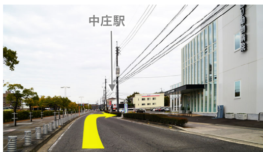
㉞ 外来用駐車場は正面と東側(中庄駅側)
